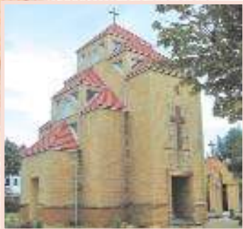
Армянская церковь в Сочи
